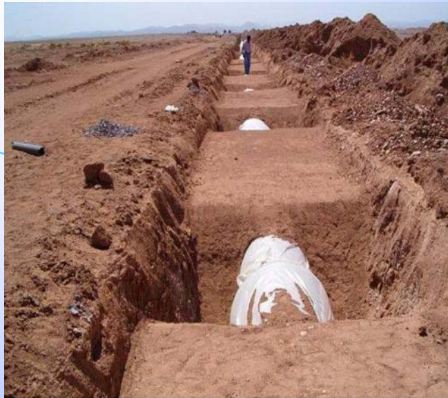
Pose et remblaiement de la conduite de refoulement de la rive droite de Ouarzazate
